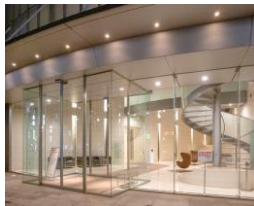
NTビル(エントランス)
