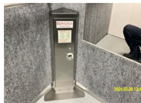
TLRレジデンス本町WEST EV内防災キャビネット
