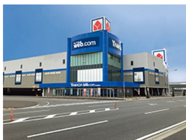
C-05 YAMADA web.com 松山問屋町店（屋上太陽光パネル）
